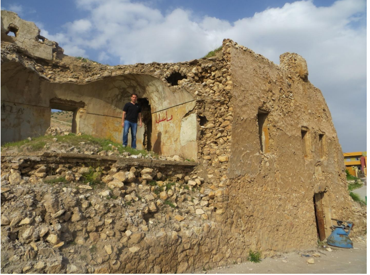
مدخل المركز وبقايا غرفة مدير الناحية – 2014
